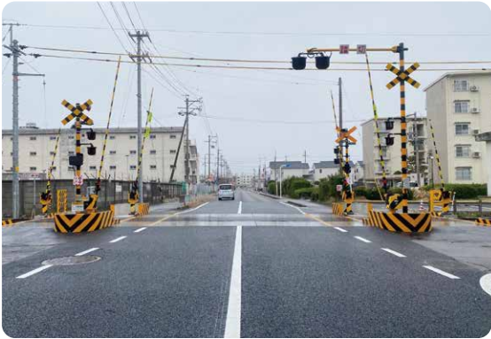
踏切拡幅工事(JR三柿野踏切)
