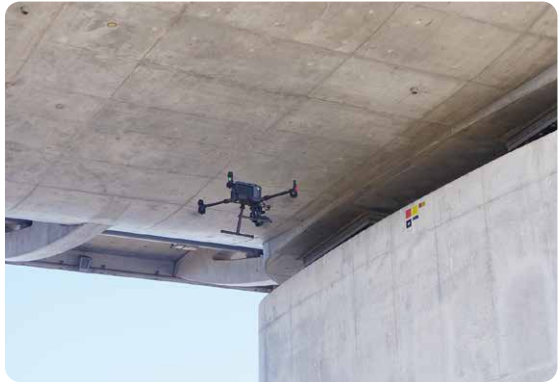
ドローンを用いた橋梁点検(各務原大橋)
