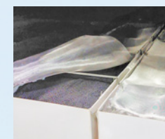
ばっき槽に活性炭を設置
