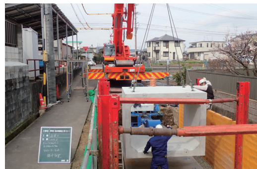
雨水幹線の整備
