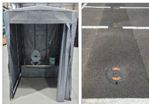
■マンホールトイレのイメージ （市内の設置事例）
