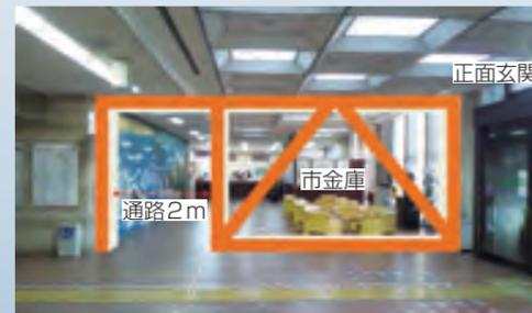
3月31日から、耐震補強したときの様子を実際に体験するため、本庁舎1階ロビーに耐震ブレースの実物大模型を設置しています。
