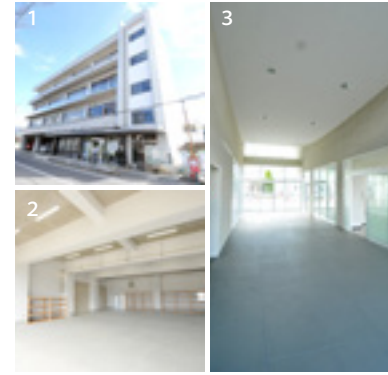
1. 現川島市民サービスセンター 2. 消防川島分署の車庫 3. 交流の場となるにぎわいロビー
