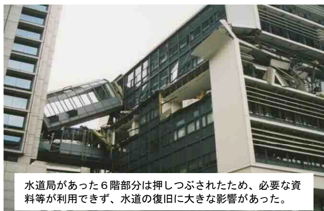
壁、柱の被害が大きく使用不能に。⇒庁舎は解体
